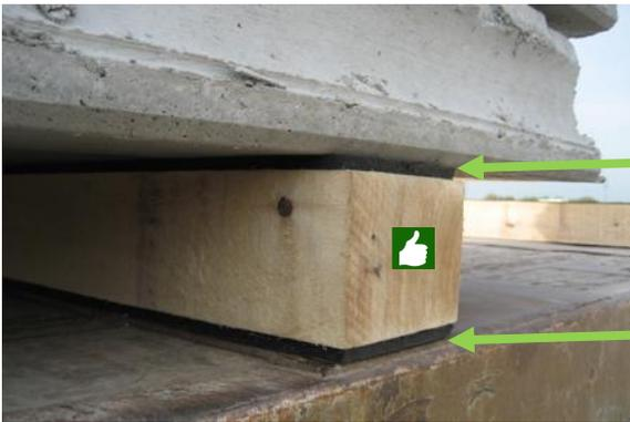
Les tapis antidérapants doivent aussi être mis entre les différents éléments du chargement.
